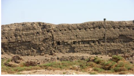
شكل (2) التموج في بناء السور المحيط لمعابد الكرنك
